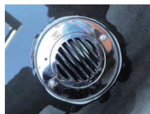
充填接着された循環用金具
